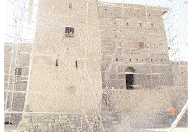
□ الحصن أثناء الترميم
