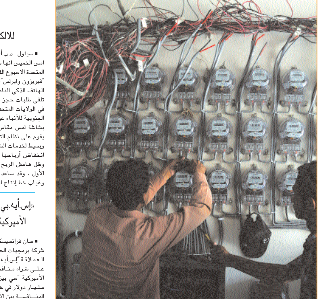
■ فنون من شركة كراتشي للإمدادات الكهربائية، أكبر شركة للإمدادات الكهربائية في باكستان، يركبون عدادات كهربائية جديدة في مبنى سكني بمدينة كراتشي أمس. وقد أعلن رئيس الوزراء الباكستاني يوسف رضا جيلاني عن خطة جذرية للتعامل مع أزمة نقص الطاقة المربة في باكستان بما في ذلك مد إجازة نهاية الاسبوع وحظر إقامة حفلات الزفاف أثناء الليل توفيراً لاستهلاك الكهرباء. وتمتلك باكستان القدرة على إنتاج حوالي ثلثي الطاقة الكهربائية المطلوبة فقط بفعل ارتفاع الطلب على الطاقة الكهربائية والديون وقلة الاستثمارات ونظام التوزيع غير الجيد. ا.ف.ب
